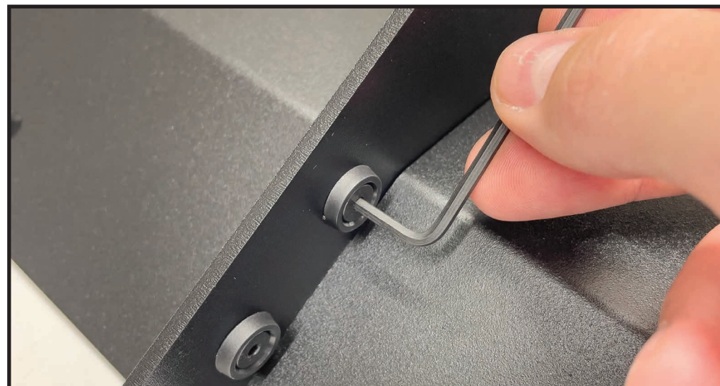
STEP 4 - INSTALLING FIN HARDWARE
