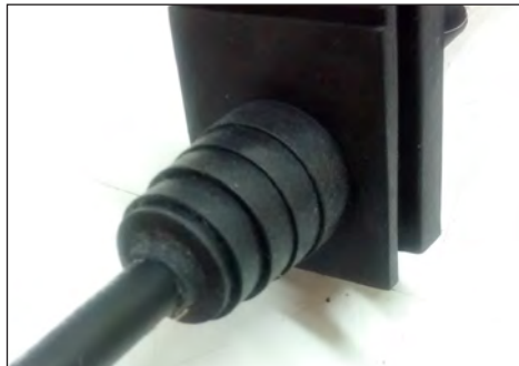
6.5. Introducir el cable óptico en la goma de sellado.
