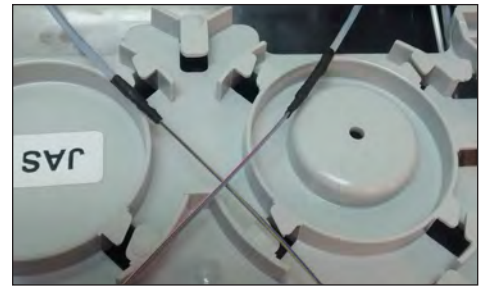
5.17. Decapar el tubo loose en las marcas con el rodillo y el cortador, limpiar las fibras y hacer el acabado con cinta autosoldable.
