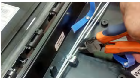
5.11. Cortar el elemento de tracción.
