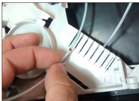
5.16. Con el tubo loose de la sangría adelantado, posicionarlo en las aletas de fijación y hacer una marca para el decapado.
