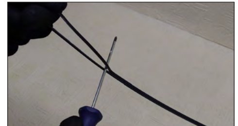
7.2. Separar el alambre de sustentación del Drop Óptico y realizar las conexiones.
