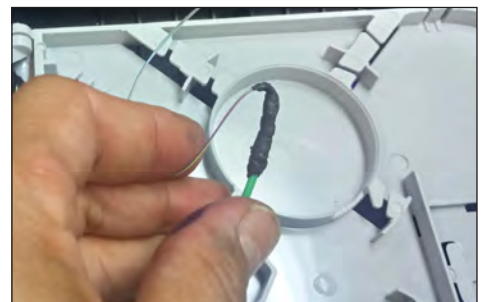
5.19. Este procedimiento es aplicado para la protección de la fibra óptica por posibles roturas en la salida del tubo loose (pié de la fibra).
