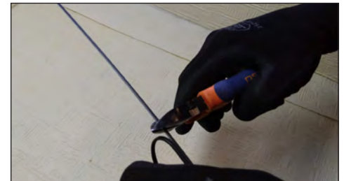
7.3. Cortar el alambre de sustentación en aprox. 400 mm de longitud.
