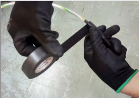
6.2. Se recomienda realizar el acabado del cable óptico con cinta autosoldable o aislante, para protección de los tubos loose.
