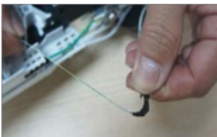
5.4. Este acabado en el “pié” del tubo loose es para realizar un “efecto resorte”, para que no haya riesgos de rotura de la fibra en este punto cuando se la manipulea.
