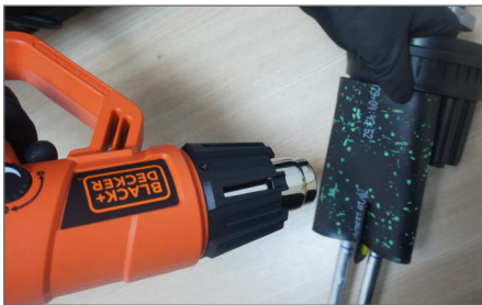
4.16. Con un soplador para alta temperatura, contraer el tubo termocontraíble hasta la desaparición de la pigmentación verde, garantizando un buen sellado.
