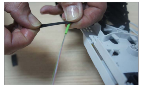
5.3. Hacer el acabado del tubo loose con la cinta autosoldable, entre la capa y la fibra óptica, manteniendo 10 mm sobre la fibra y 20 mm sobre el tubo loose.
