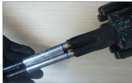
4.17. Luego de la finalización, verificar el sellado del cable.
