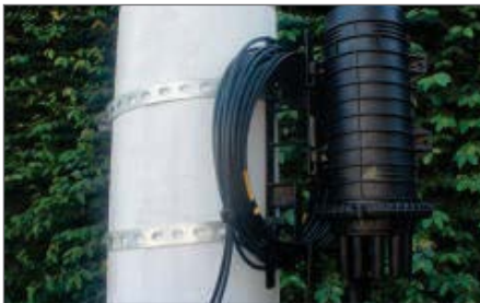
7.1. Instalación en poste.
