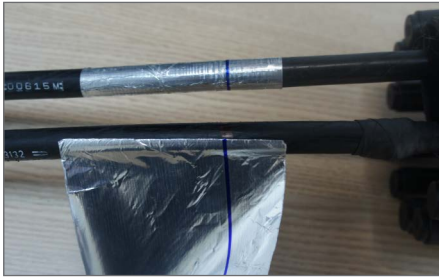
4.13. Fijar las cintas adhesivas de aluminio en los dos cables ópticos.
