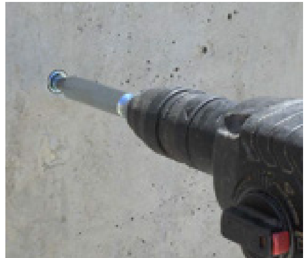
Inserción del anclaje con la herramienta de inserción SDS.
