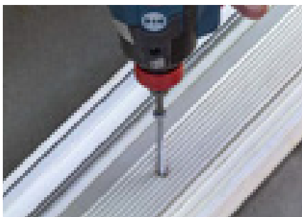
Instalación de riel de puerta corrediza
