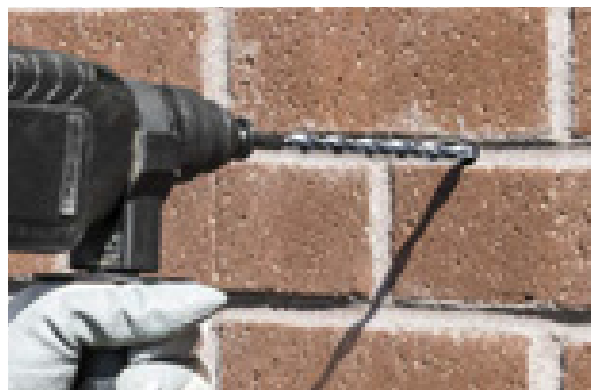
Amarre helicoidal para pared Heli-Tie
