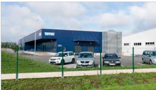
Am Januar 2022 wurde eine neue Halle mit einer Nutzfläche von knapp 3.000 m 2 genehmigt.
