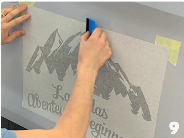
Mit einer Rakel das Wasser von der Mitte her nach aussen in überlappenden Bahnen ausstreichen, bis sich die Klebefolie nicht mehr verschieben lässt. Oberfläche nachtrocknen.
