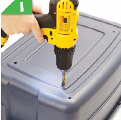
À l'aide d'une perceuse, faire huit trous en dessous d'un bac en plastique opaque afin que l'excès d'humidité puisse sortir du bac. Mettre un tapis en plastique en dessous du bac, au cas où il y aurait des fuites. Une astuce consiste à installer de petits blocs de bois aux quatre coins de votre bac afin de permettre à l'eau de bien s'écouler et à l'air de circuler.
