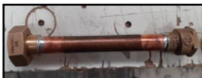
En otro tubo soldar el terminal HI y al otro extremo soldar contiene la tuerca de la unión americana para gas.
