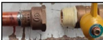
Aplique teflón en el conector HE de la llave de paso y roscar el terminal SO HI y la pieza Unión americana.
