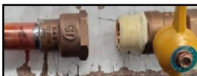
Une la pieza **A** con la **B** y aprieta la tuerca con una llave ajustable para lograr el sello de la unión.
