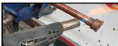
Calentar con soplete, una vez lograda la temperatura adecuada, soldar y dejar enfriar.
