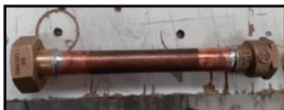
Aplique teflón en el conector HE de la entrada de gas y roscar el terminal SO HI soldado en el tubo y la pieza de la unión americana, apretar con llave.
