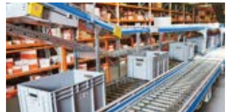
コンベアシステム
