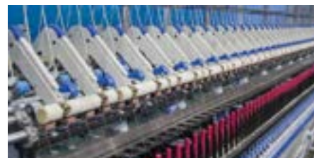
Automatisation de machines à filer
