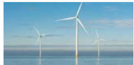
Instalaciones en alta mar
