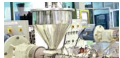
Monitorización de nivel en la producción de plástico
