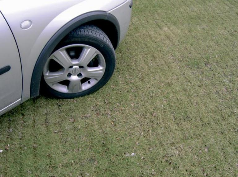
Die WKH Rasengitter aus Kunststoff werden zur Verbesserung der Befahrbarkeit von Grünflächen eingesetzt. Sie verhindern eine Flächenversiegelung und fördern so den Grundwasserhaushalt.
