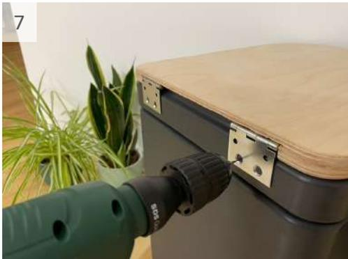
7 Befestigungspunkte im Kunststoff mit einem Bohrer vorbohren. Ggf. das Scharnier mit einem Senkkopf versehen.
