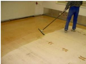
**Vorarbeiten:** Untergrund gründlich reinigen, fettfrei, trocken, Oberfläche anschleifen, strahlen usw. Restfeuchte: unter 4%
