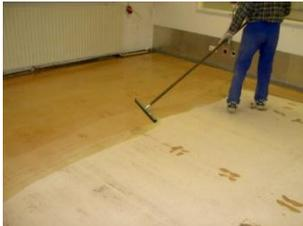
**Vorarbeiten:** Untergrund gründlich reinigen, fettfrei, trocken, Oberfläche anschleifen, strahlen usw. Fehlstellen, Löcher usw. vorab mit Nr. 13 ALFO-POX Kunststoff verspachteln, ausfüllen.
