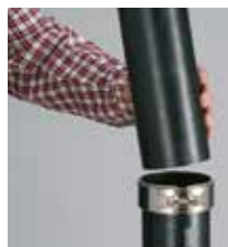
Skjut in det andra röret så att det möter mittrillan.
