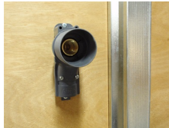
Gipsdåse Monteret på bagvæg.
