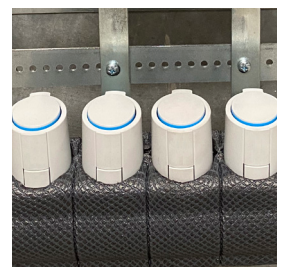
Max. bestykning af et BUNDMODUL for at det kan være i et 60 cm skab. 12 GV, 16KV og 9VV.
