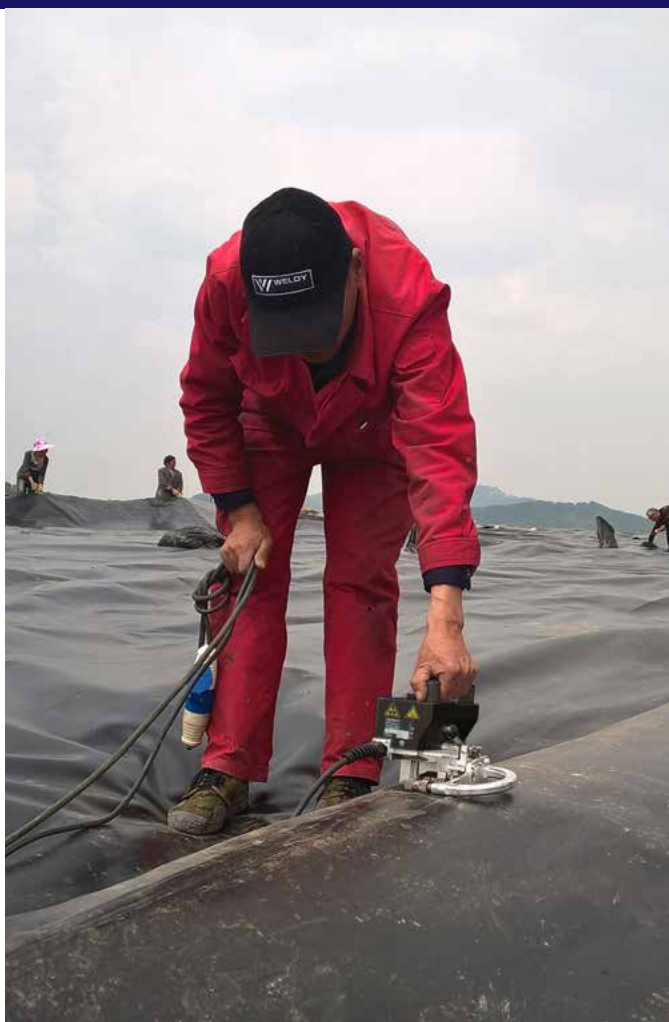
156.617 (230 V) 156.204 (120V) Cuneo caldo, 56 x 36 mm Rame con canale di prova
