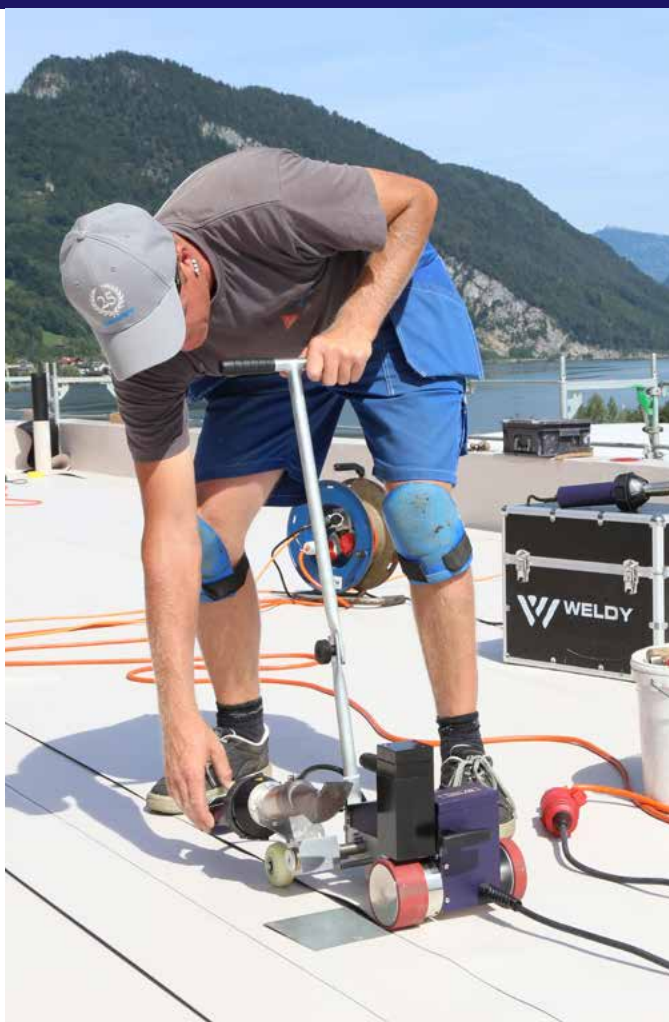
123.287 Ugello saldature a sovrapposizione 40 mm
