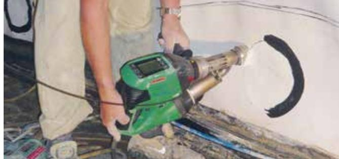
Il robusto WELDPLAST S2 durante la saldatura di una "patch" ("pezza") nella costruzione di tunnel.
