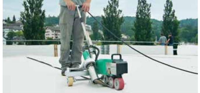
Elevata sicurezza di processo anche con sottotensione.
