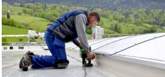
Sopra e a lato degli attici, per la saldatura di cupole luminose, giunti o piccole terrazze, l'UNIDRIVE 500 è convincente anche con spazi ridotti.
