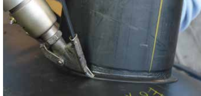
Tirare la saldatura con ugello combinato.
