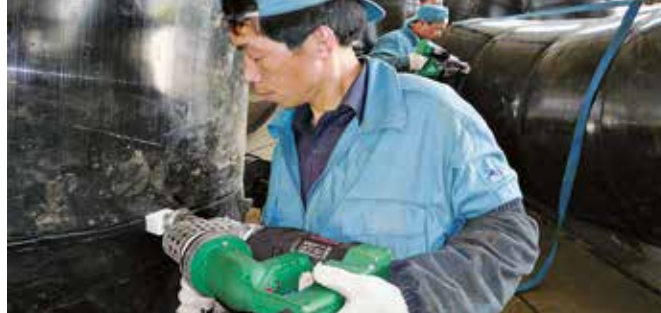
Applicazioni di FUSION 2 nella costruzione di serbatoi.
