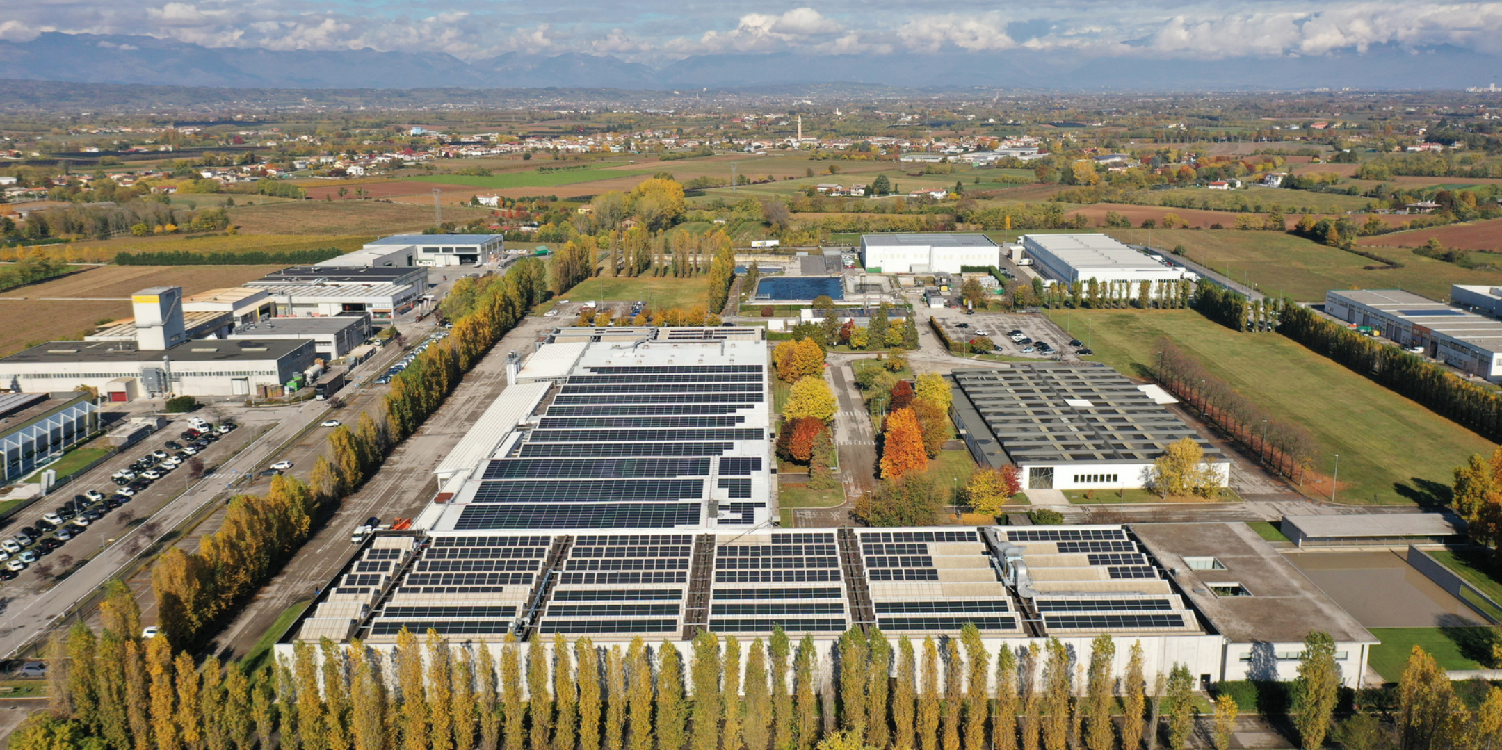
Impianto fotovoltaico Stabilimento di Ponzano Veneto (TV)
