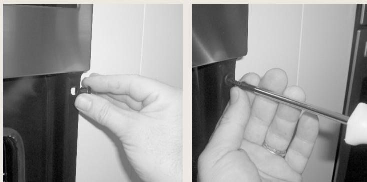
Fixez les douilles au meuble avec les quatre vis fournies en veillant à ne pas trop forcer sous peine de casser les douilles.
