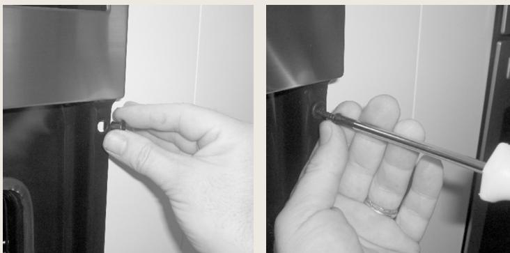
Met de vier bijgeleverde schroeven de moffen vastmaken aan de kast en ervoor zorgen dat niet teveel kracht wordt uitgeoefend om de mof zelf niet te breken.
