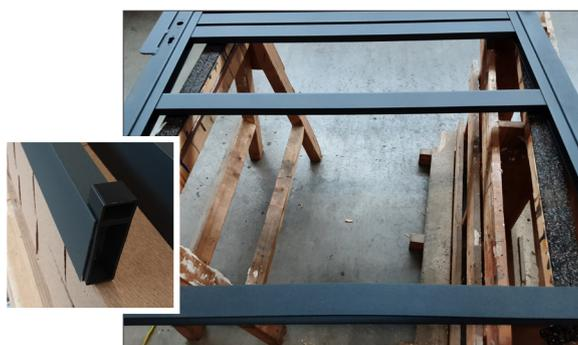
4. Verschraube die unterste Lamelle durch die Flacheisen der Tür.
