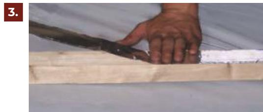
3. Die sichtbaren Oberseiten der Unterkonstruktion müssen hell bzw. lichtreflektierend sein
