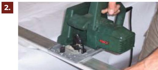
2. Verlegeprofile auf die passende Länge zuschneiden
