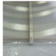
Ist eine Platte komplett befestigt, wird die obere Schutzfolie abgezogen. Die unten Schutzfolien werden entfernt.
