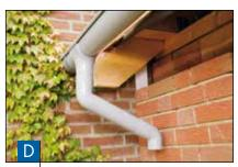
Die Einzelteile des Fallrohrsystems werden einfach zusammengesteckt. Wegen der Einstecktiefe der Formteile werden keine Dichtungen benötigt.
