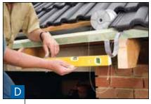
An der Richtschnur das Gefälle noch einmal überprüfen, auf 10 m Dachrinne sollten 2 bis 3 cm Gefälle eingeplant werden.
