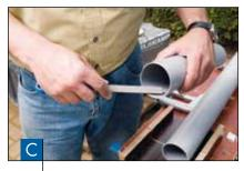
Die Schnitt-Enden des Fallrohrs sauber entgraten, besonders beim Einbau eines Marley Regensammlers kann dadurch die Auffangleistung erheblich gesteigert werden.
