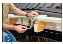
Die abgebogenen Rinneneisen in den Aussparungen an der Dachlatte mit Spaxschrauben oder entsprechenden Nägeln befestigen.
