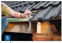
Das erste Rinneneisen an dem Dachstein ausrichten: Die Vorderkante des Dachsteins muss ½ in die Rinne hineinstehen. Das letzte Rinneneisen mit 2 bis 3 cm Gefälle auf 10 m montieren.
