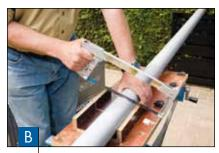
Marley Fallrohre lassen sich einfach und schnell mit einer feinzahnigen Säge trennen. Tipp: Um einen geraden Schnitt zu erhalten, sollten Sie eine Gehrungslade verwenden.
