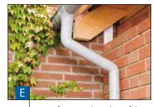
Die Befestigung der Rohre erfolgt mit Rohrschellen, die an der Hauswand mit Dübeln fixiert werden. Dabei wird zwischen "Festschellen" und "Losschellen" unterschieden.
