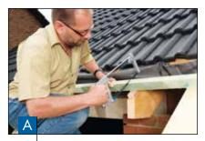
Abstand der Rinneneisen 50 bis 70 cm. Sägen Sie in die erste Dachlatte Schlitze in der Breite des Rinneneisens, Schlitze ausstemmen, damit die Eisen bündig in die Dachlatte eingelassen werden können.
