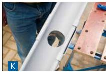
Die Sägekante entgraten und den Rinnenstutzen über die hintere Abkantung einhängen und über den vorderen Wulst klippen.
