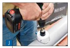
Das Aussägen des Ablaufloches geht schnell und sauber mit einem Lochsägeaufsatz oder einer feinzahnigen Säge.
