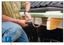
Vor der Befestigung müssen die Rinneneisen abgebogen werden. Das Abbiegen geht am einfachsten mit einer großen Kneifzange, wie im Bild dargestellt, oder im Schraubstock.
