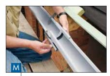
Die Verbindungsschale wird über die hintere Abkantung eingehängt und über den vorderen Wulst geklippt. Markierungen beachten -Nocke-Nut-System!
