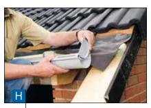
Die Dachrinne mit einer Metallsäge auf die passende Länge zuschneiden und in die Rinneneisen legen. Das Endstück wird einfach aufgesteckt.
