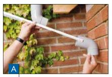
Auf den Stutzen einen Bogen aufstecken und den Abstand zum Gegenbogen messen. Dabei die Einstecktiefe von 4 cm und den Abstand zur Hauswand berücksichtigen. Bei schmalen Dachüberständen werden 2 Bögen mit dem Bogenverbinder direkt verbunden.
