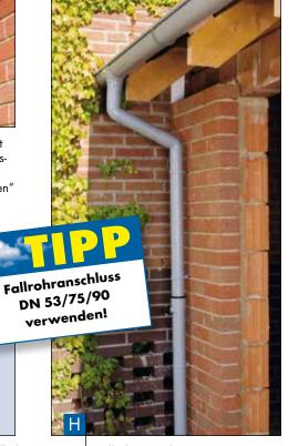
Mit einer "Losschelle" wird das Fallrohr in der Mitte oder am unteren Ende geführt. Dabei werden Ringschraube und Unterlegscheibe zwischen die Laschen der Rohrschelle montiert. So kann sich das Rohr in der Schelle bewegen und Längenänderungen infolge von Temperaturschwankungen ausgleichen.
