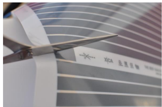
Figur 3.5 Klipp i klippesone på varmemefolie.
