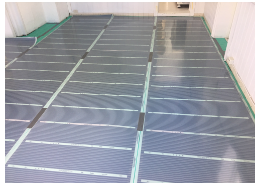
Figur 4.2 Rull ut varmemefolie i henhold til skisse, Leselig og lys side opp.
