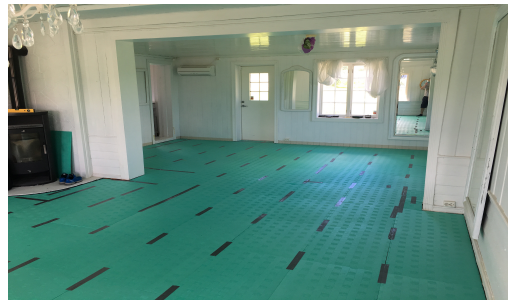
Figur 4.1 Legg ut Secura 6mm på hele arealet
