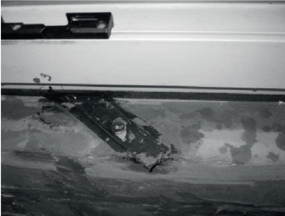
Bild 5 Montagekonsolen unten
