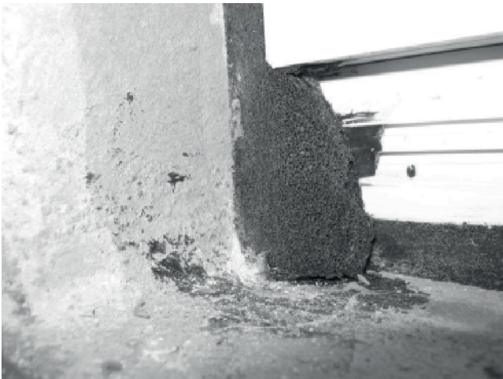
Bild 2 Eckausbildung unterer Anschluss raumseitig
