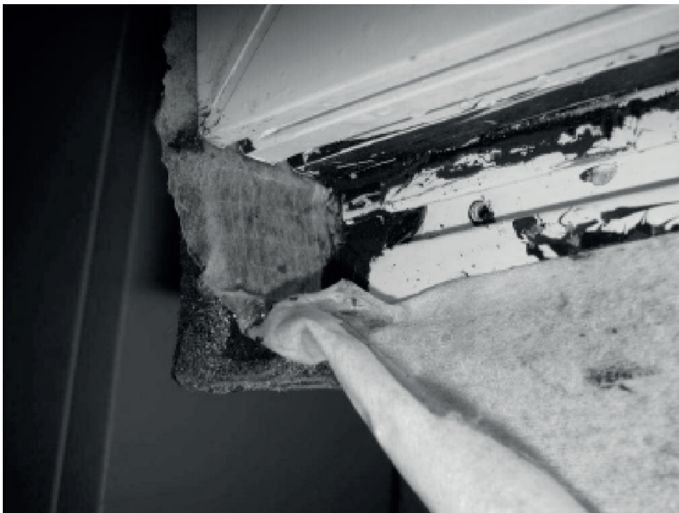
Bild 8 Detailansicht demontierter FOLIENANSCHLUSS unten
