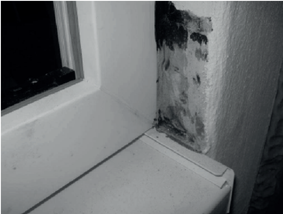
Bild 1 Eckausbildung des unteren Anschlusses außen
