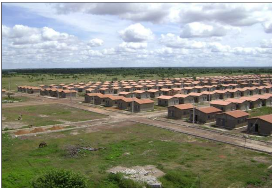
Figura 2 – Fotografia da visão panorâmica do Conjunto Habitacional Renascer I em Campo Maior (PI)
