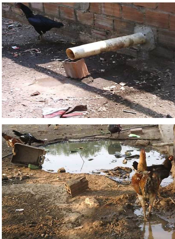
Figura 3 – Pontos de descarte irregular de resíduos líquidos
