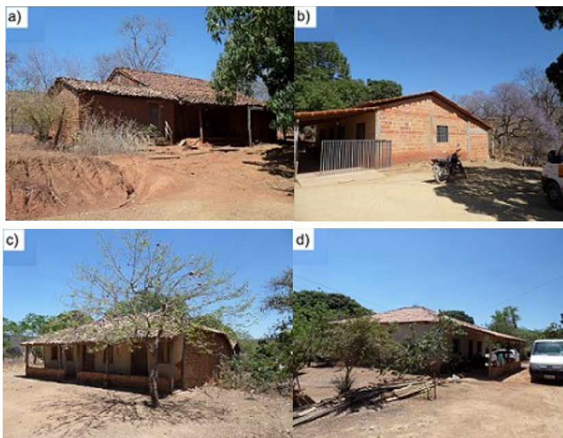
Figura 6 – Construções antigas (a e c) que foram substituídas por novas construções (b e d)
