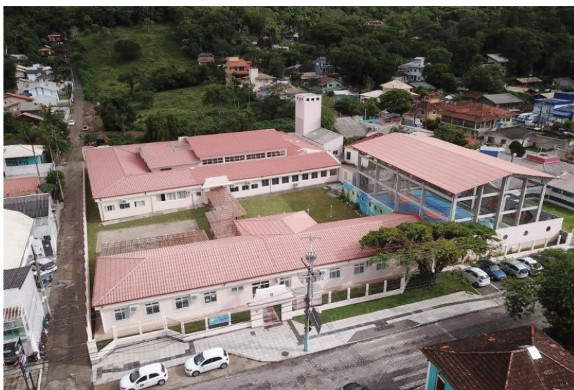
Figura 2 – Vista aérea da EBM Henrique Veras
