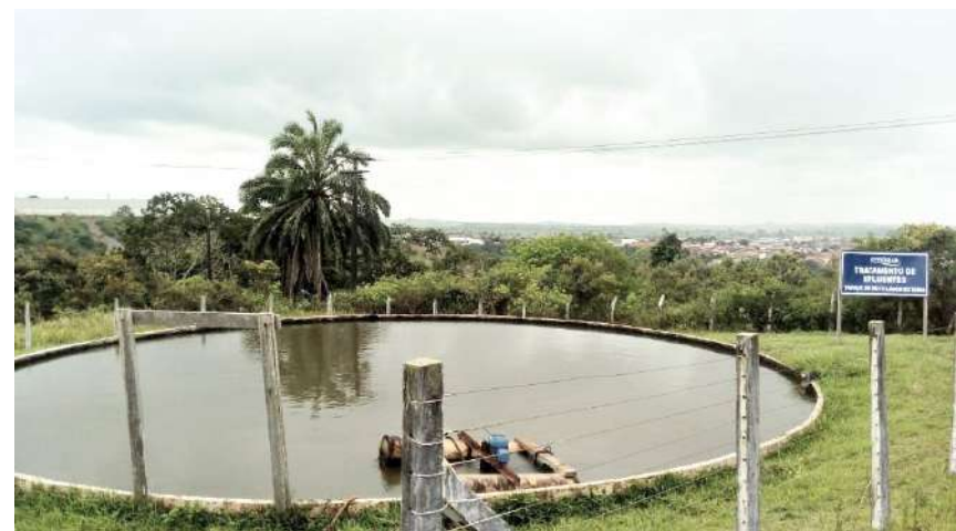
Figura 17 – Estação de Tratamento de Efluentes da EMBASA
