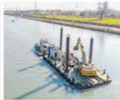
Eine schwimmende Plattform mit Bagger ist für Rhesi im Einsatz. »A8
