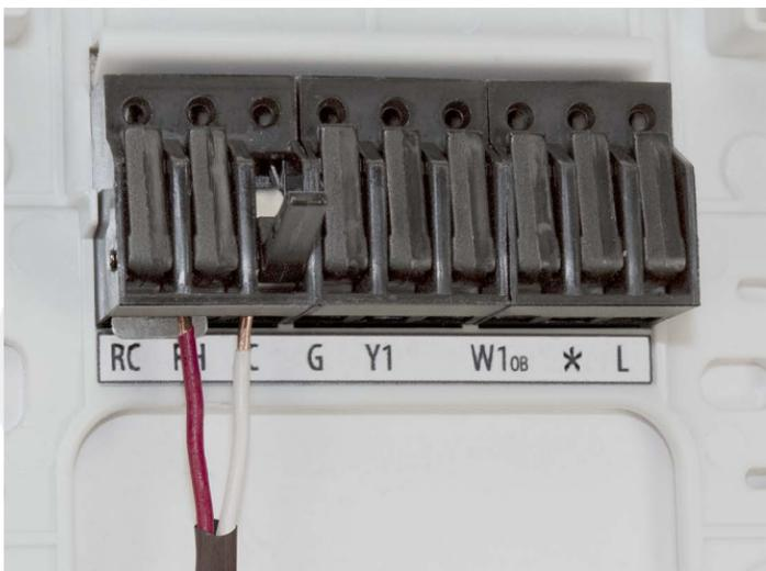
**Raccorder les fils :** Pour insérer un fil dans une borne, soulever la languette de verrouillage et glisser le fil dans le logement juste au-dessus de l'étiquette correspondante. Insérer chaque fil requis pour l'appareil. Après avoir placé chaque fil, rabattre la languette pour le verrouiller en place. Tirer légèrement sur chaque fil après l'avoir verrouillé, pour vérifier qu'il est solidement fixé.
