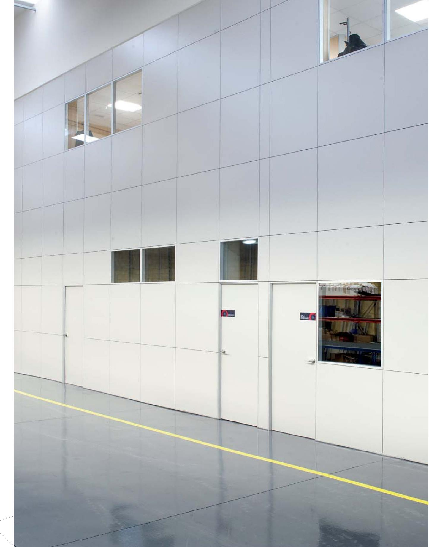
Los entornos industriales requieren soluciones para sus espacios de trabajo. En esta instalación alcanzamos los 7 metros de altura para cubrir el frontal de la entreplanta. Industrial environments require solutions for their work spaces. In this installation we reach 7 meters high to cover the front of the mezzanine.
