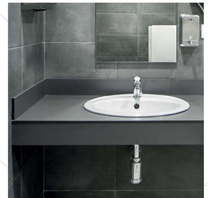
Las encimeras se sujetan a la pared mediante escuadras de alta resistencia y pueden reforzarse con patas en la parte frontal. En la parte superior se rematan mediante un copete y en la parte inferior llevan un faldón para cubrir los lavamanos y sistemas de desagüe.
