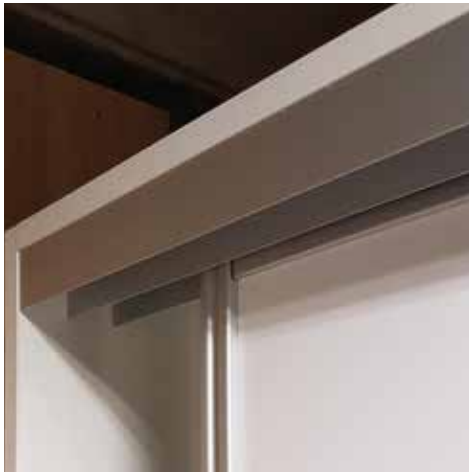
1. Yläkisko kiinnitettyinä kaapiston kattoon
