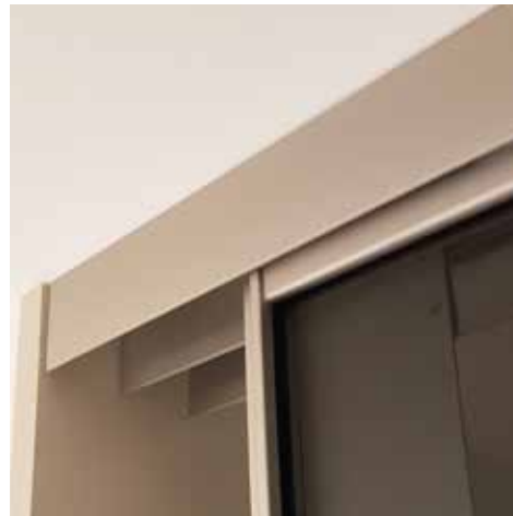
2. Yläkisko kiinnitettyinä huoneen kattoon
