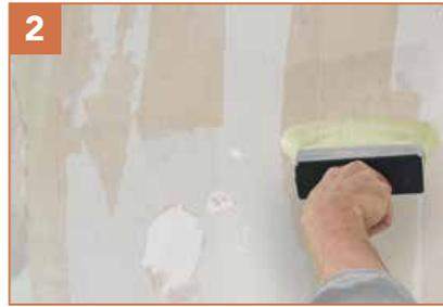
2. Tapezieren Sie auf eine Wand der den Kleister Aufsaugen wird? Dann ist es Wünschenswert die Wand vorzubearbeiten mit Grundiermittel.
