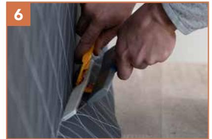
6. Schneiden Sie die überschüssigen Kanten mit einem scharfen Cuttermesser ab. Drücken Sie die Kanten mit einer Spachtel nochmal extra an.
