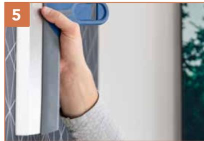
5. Überprüfen Sie ob Ihr eigenes Design korrekt auf der Tapete gedruckt wurde. Drücken Sie die Tapete mit einer Spachtel oder Rakel an der Wand. Am besten von Oben zur Mitte und dann nach Aussen.
