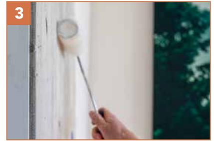
3. Streichen Sie die Wand mit einer grossen Schicht Tapetenkleister ein. Bringen Sie bis zu maximal ein bis zwei Meter Tapetenkleister an, sodass dieser nicht austrocknen kann.
