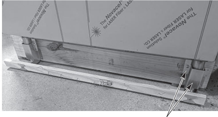
RETIRE LOS SOPORTES DE ENVÍO (4 LUGARES)
