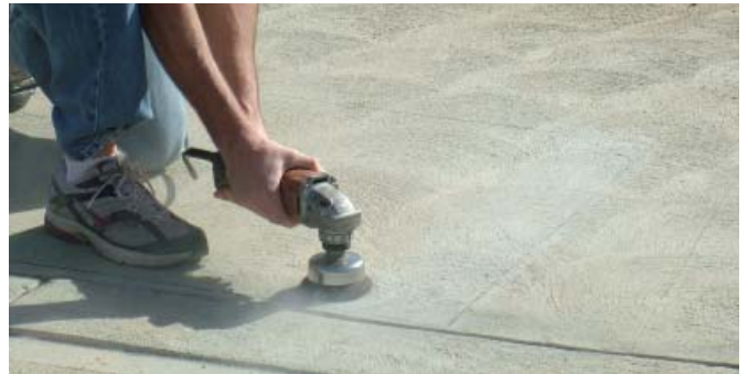
Grind surface. Pulir la superficie.
