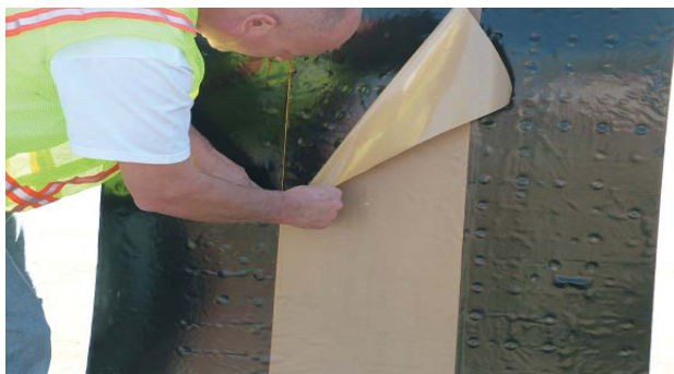
Remove paper backing. Remover el papel de respaldo.
