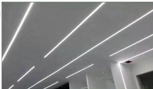
Perfil micro para tiras LED en techos de pladur o escayola, para una iluminación lineal invisible integrada.
