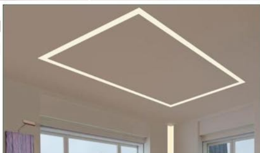
Perfil ancho de pladur para tiras de LED con una iluminación más arquitectural para iluminar utilizando tiras de alta potencia.
