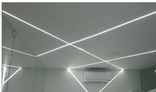
Perfil compuesto por dos partes una guía para canalizar el cable y el aluminio para instalar la tira de LED. Difusor óptico con grados.
