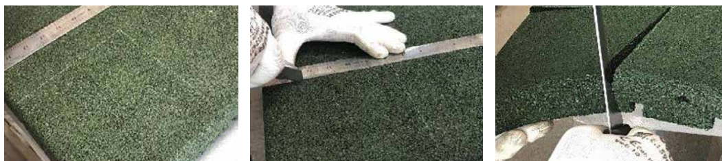
Zuschneiden der Platten für passgenaues Verlegen an Kanten
