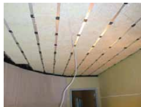
音シャットフレーム間に ロックウール80k40mm厚を充填
