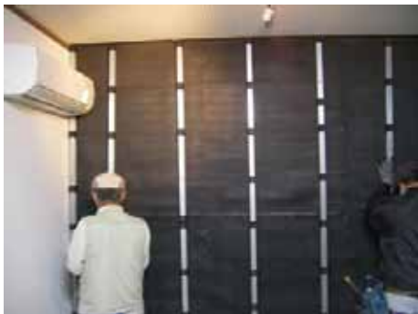
壁：音シャットフレーム 455mmピッチで施工
