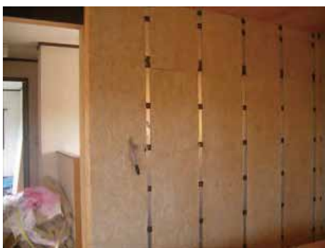
音シャットフレーム間に ロックウール80k40mm厚を充填
