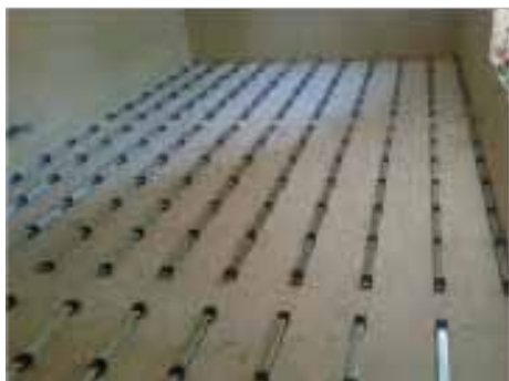
床：音シャットフレーム 303mm ピッチで施工
