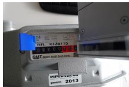
Montage oberhalb des Zählwerks
