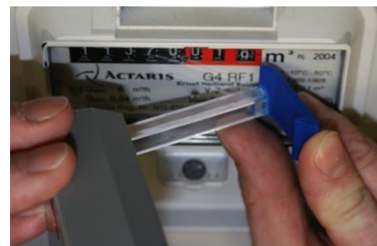
Ansetzen des blauen Clips unterhalb des Zählwerks
