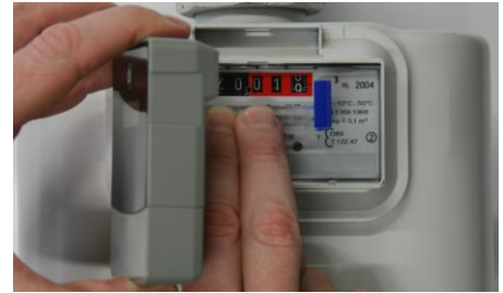
Festkleben des Befestigungsbügels
