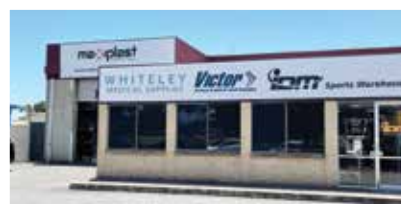
SA Store & Warehouse
