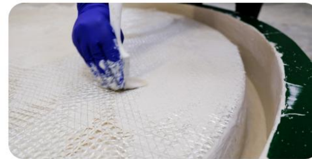
Penktas žingsnis Sudrėkinkite mišinį ir užtepkite Quadaxial Glass Fabric ant liečiamo sauso sluoksnio.
