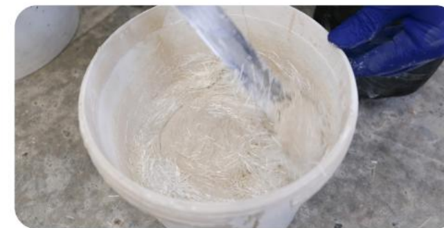
Septintas žingsnis Pasirinktinai sukurkite susmulkintomis sruogomis sustiprintą premiksą ir pritaikykite tolesniam stabilumui.
