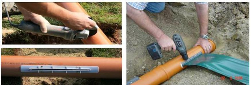
Das offene Ende des Riemens ca. 2 bis 3 cm in den Connector schieben (je nach Temperatur muss der Streifen etwas zusammengeschoben werden) und mit Schrauben gegen Herausziehen sichern.
