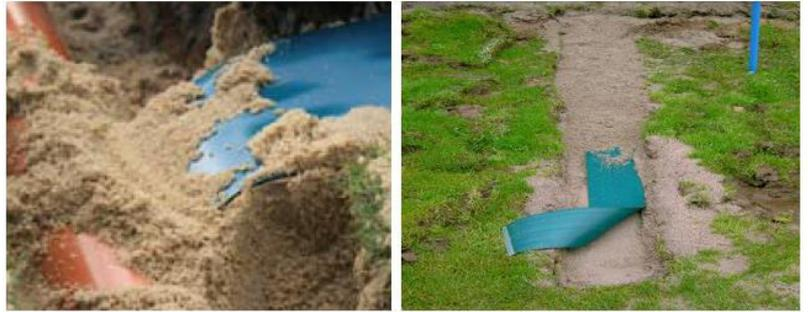
**WICHTIG: DIE GRÄBEN IMMER VOM CONNECTOR IN RICHTUNG ABGEKLEBTEM ENDE VERFÜLLEN, DAMIT KEINE „WELLE“ ENTSTEHT.**
