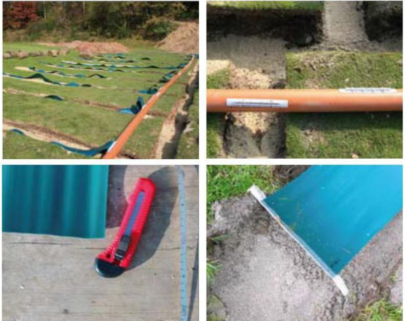
**DAS BANDENDE, AN DEM DAS WASSER AUS DEM DRAINBELT HERAUSLAUFEN SOLL, IST DER TIEFSTE PUNKT VOM DRAINBELT-STREIFEN. DIE HÖHENDIFFERENZ BIS ZUM AUFTREFFEN AUF DEM ABLAUFROHR/DEM CONNECTOR SOLLTE MINDESTENS 15 CM BETRAGEN. NUR SO ENTSTEHT DER OPTIMALE SAUGEFFEKT. WENN DU DAS WASSER VERSICKERN LASSEN WILLST, IST AUCH HIER DER ABFALL AM BANDENDE IM GELÄNDE ZU FIXIEREN. DRAINBELT SOLLTE DABEI LANGFRISTIG VOR UV-STRAHLUNG GESCHÜTZT SEIN (ABGEDECKT WERDEN).**
