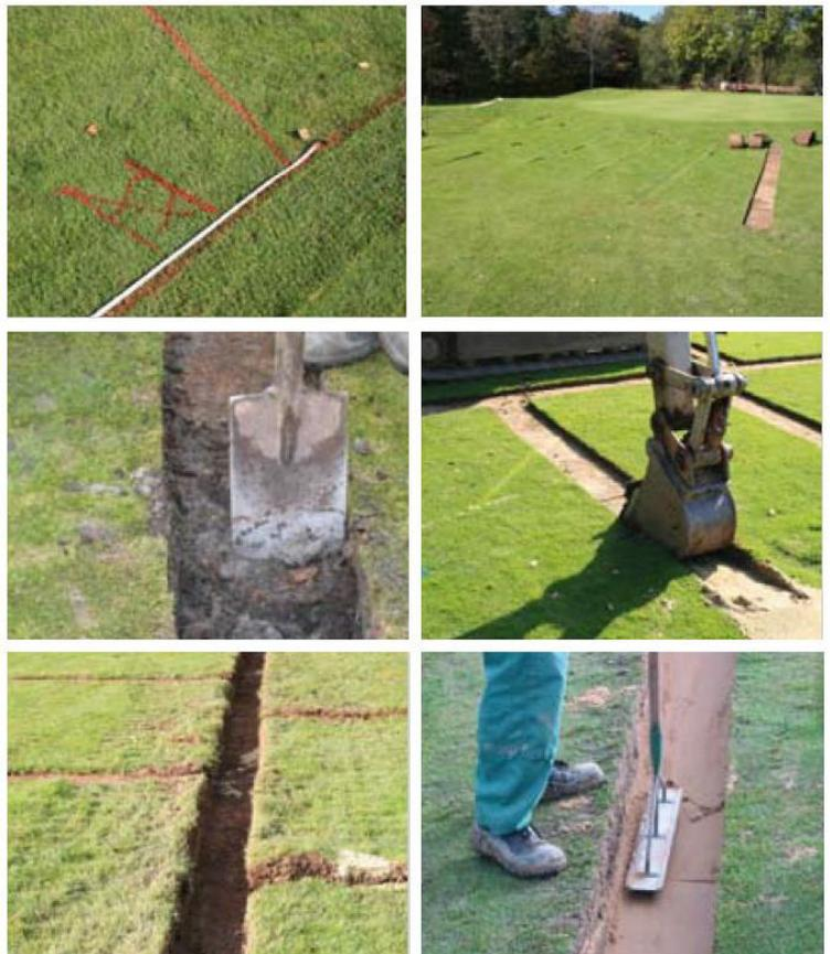
**UM DIE EMPFOHLENEN BANDLÄNGEN NICHT ZU ÜBERSCHREITEN, MUSST DU DIE FLÄCHE MIT ENTWÄSSERUNGSRÖHREN UNTERTEILEN. DAFÜR KANNST DU ZUM BEISPIEL KG-ROHRE VERWENDEN. BITTE BEACHTE BEI DER ABLEITUNG DIE RECHTLICHEN VORSCHRIFTEN. DAS DRAINAGEWASSER DARF NICHT EINFACH ÜBER DAS ABWASSER ENTSORGT WERDEN.**
