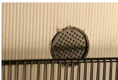
Vue de l'arrière de la cave
