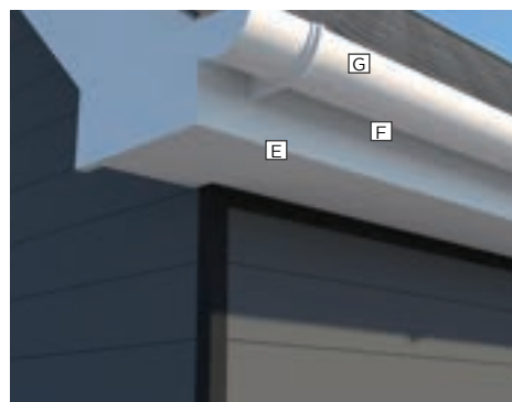
E - Soffit F - Fascia G - Guttering
